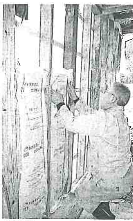
遅れて届いたグラスウールを設置する工務店の男性＝秋田県大仙市、斉藤写す
