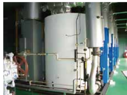
炉筒煙管ボイラ
