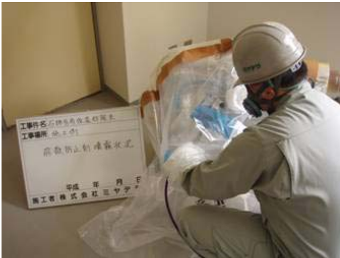
再度飛散防止液 浸透
