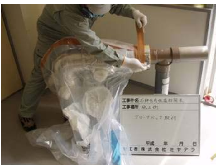
グローブバッグ取り付け作業
