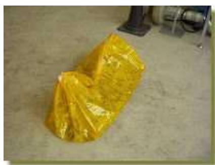
石綿は完全密閉され搬出
