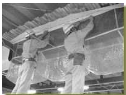
取り付け作業は静かでクリーン
