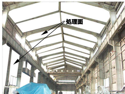
ラッピング工法で処理された工場
